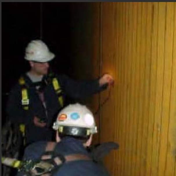
▲ 锅炉内的水冷壁管现场
