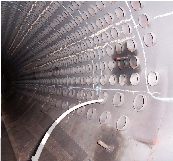
▲ 锅炉管束的检测
