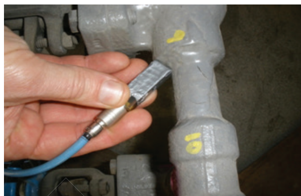
▲ 接口焊缝的检测
