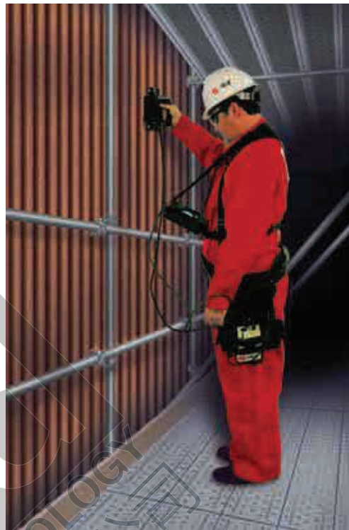
快速检测锅炉水冷壁
