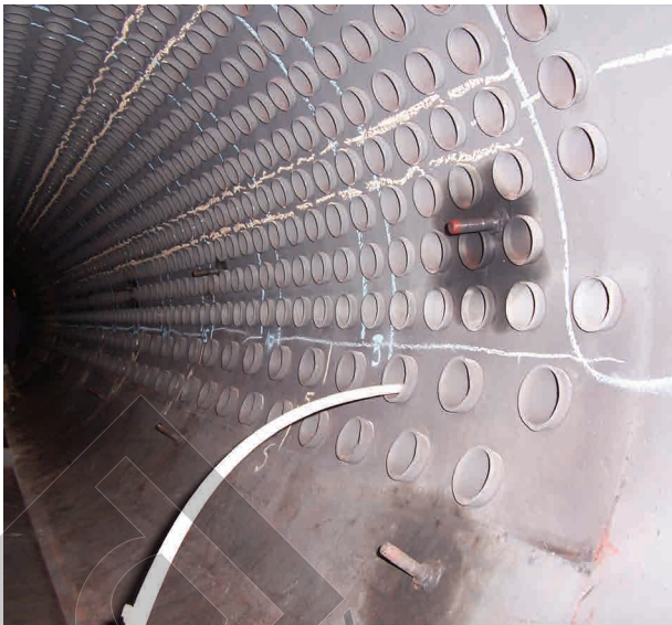
▲ 锅炉管束的检测
